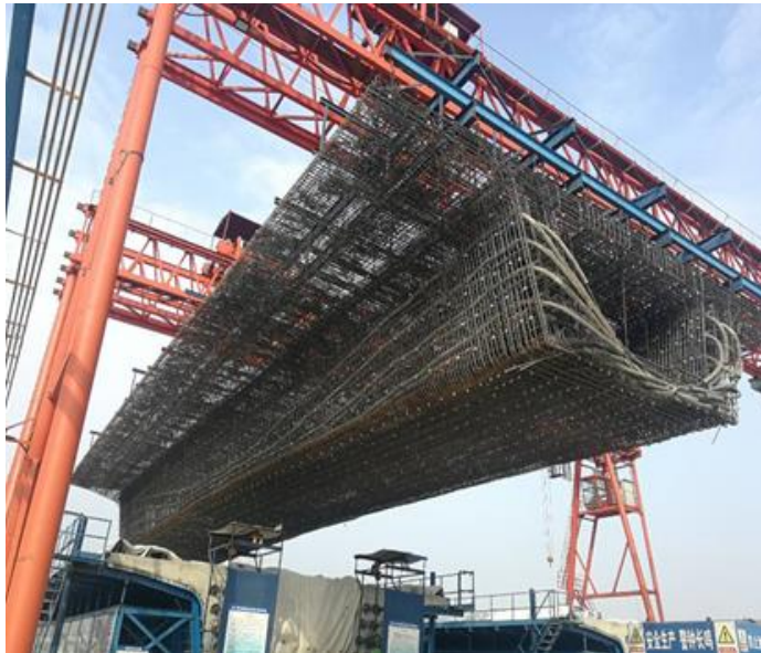
Figur 21: Foto som visar lyft av armeringskorg.
