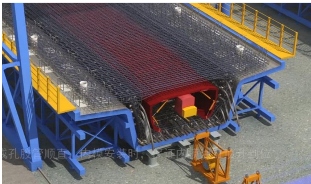
Figur 19 : Figur över hur armeringskorgen till brobanan byggs upp.
