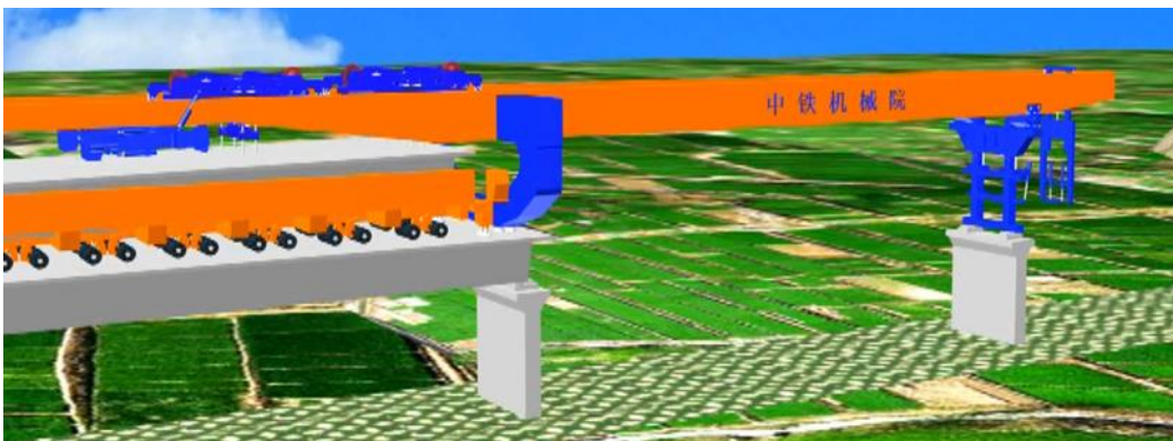
Figur 32 : Nytt brobane element är framkört och lyftning förbereds.
